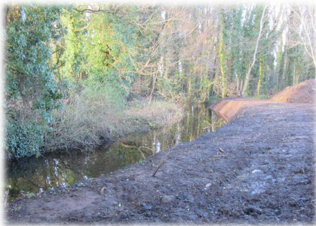
Scéim Faoisimh Tuile Dheisceart na Gaillimhe, Thalamh Íseal an Ghoirt - mar réamhobair le haghaidh na scéime, rinneadh oibreacha glanta cainéil ar shúmairí Chreig an Róistigh
