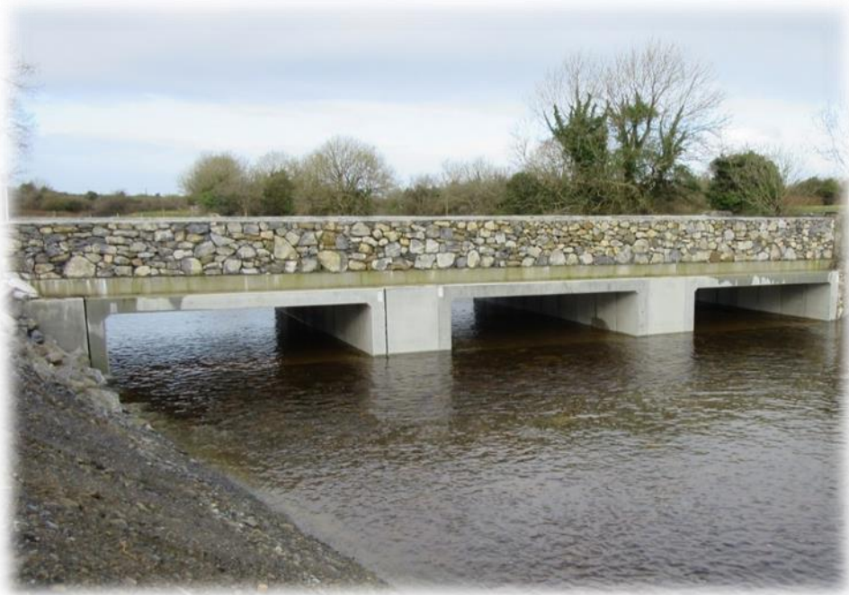
Scéim Faoisimh Tuile Abhainn Dhún Coillín & Shruthán an Agaird - Tuile-shúile nua-shuiteáilte ar Dhroichead na Rinne agus iad ag feidhmiú
